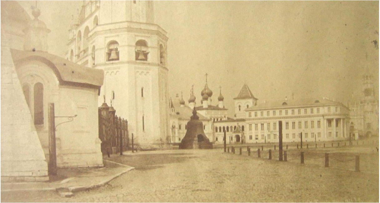
1. Джованни Бианки. Une vue du Kremlin Moscou [Кремлевская площадь в Москве]. 1855 // ОЭ РНБ. Э ФТ63/5–М821. Эф 1711.
