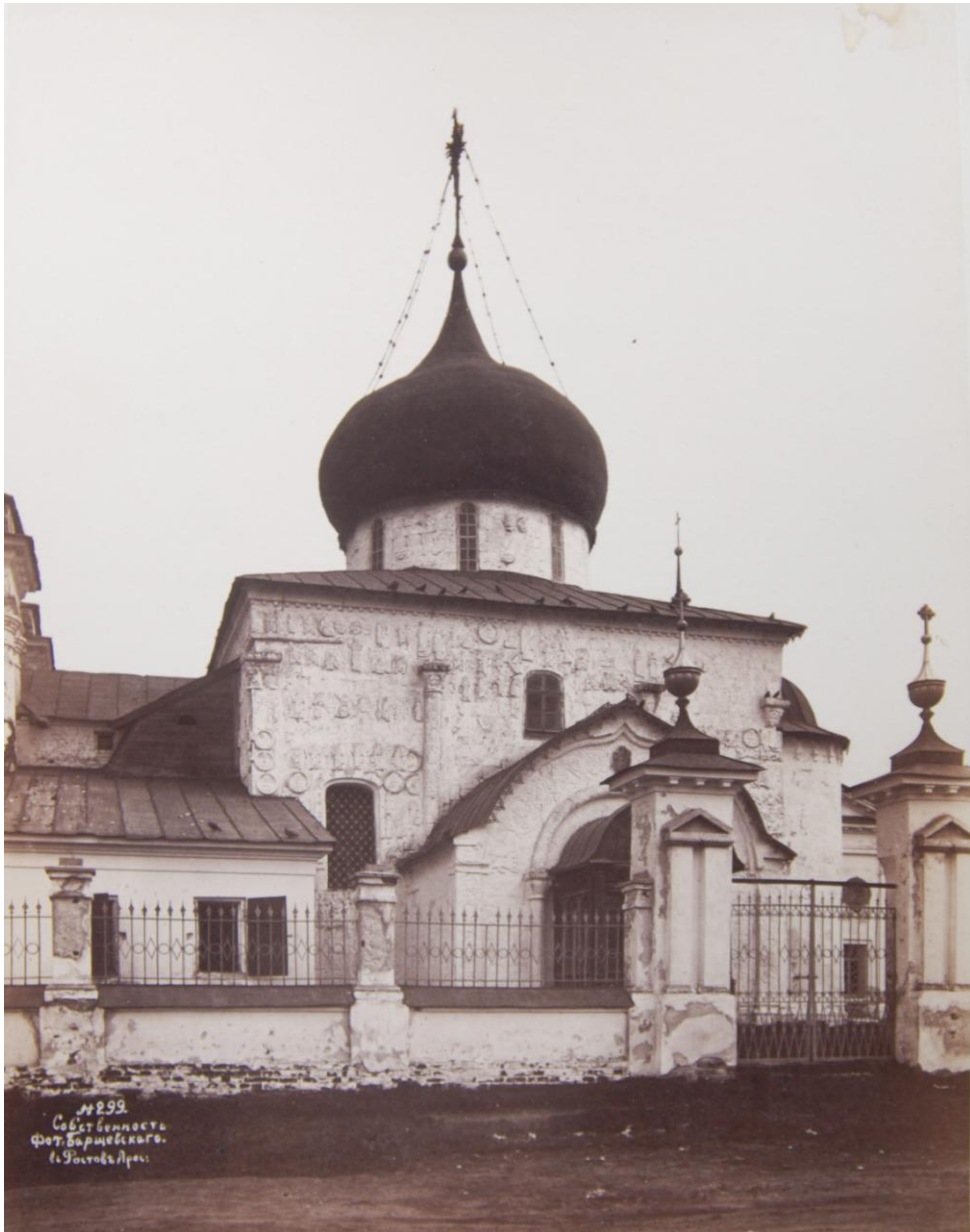
11. Барщевский И.Ф. Георгиевский собор с южной стороны (...) в Юрьеве-Польском // НА ИИМК РАН. ФА. Q 207.54.
