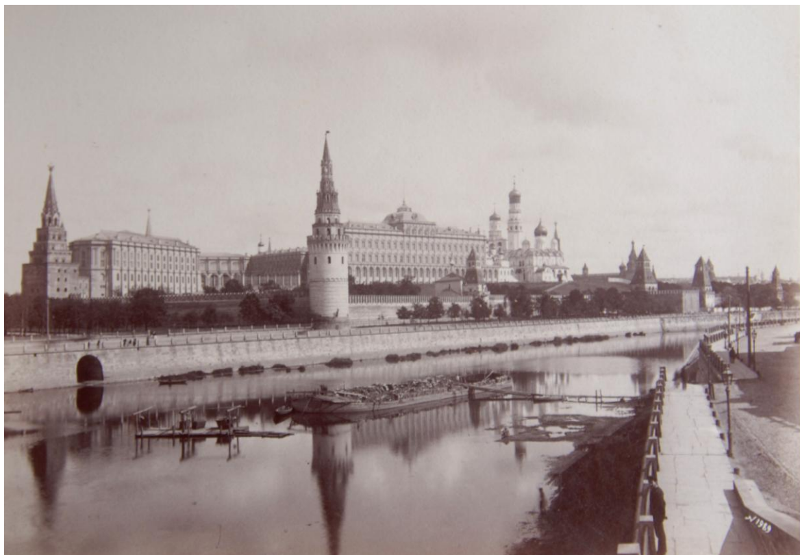
24. Барщевский И.Ф. Вид на Кремль с Каменного моста в Москве // НА ИИМК РАН. ФА. О. 514.37.
