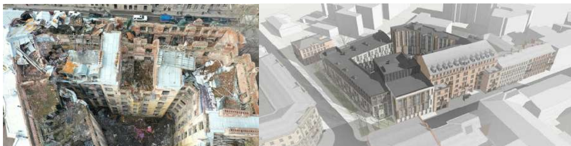
Рис. 2.7. Внешний вид Дома Басевича на 2020 г. (слева) и изначальный проект реконструкции (справа) (составлено автором на основе https://kultfond.com )
