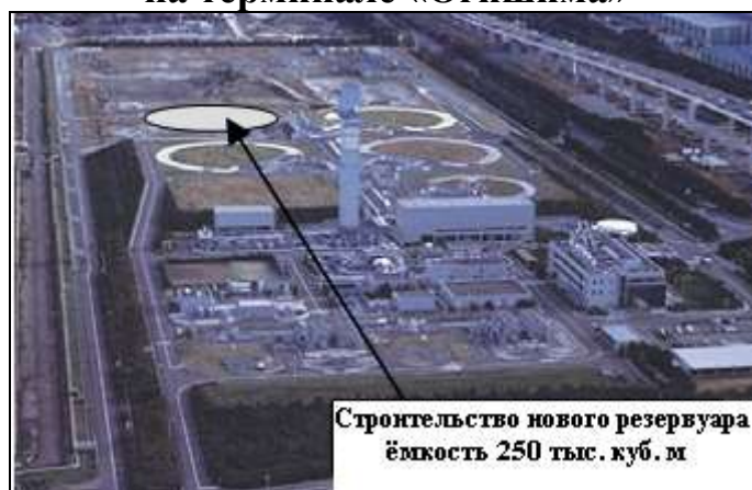
Рисунок 5. Строительство нового подземного резервуара на терминале «Огишима»
